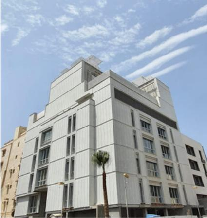
يعد مشروع عمارة الدكتور عبدالله بن جنيدب في جدة من أبرز المشاريع التي تم تنفيذها بفضل تكامل وظائف نظام EIFS، مما ساهم في تحقيق كفاءة عالية في العزل الحراري بقيمة  $U\text{-Value: } 0.2\text{W/m}^2\text{.C}$ . هذا الأداء الاستثنائي يساعد في تخفيض استهلاك كهرباء التكييف بنسبة تصل إلى 80٪، مما يجعله نموذجًا في الاستدامة وكفاءة الطاقة. الموقع ..... جدة
